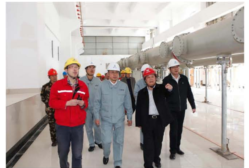
祁宁春总经理、毛学工副总经理一行检查桐子林水电站工地
