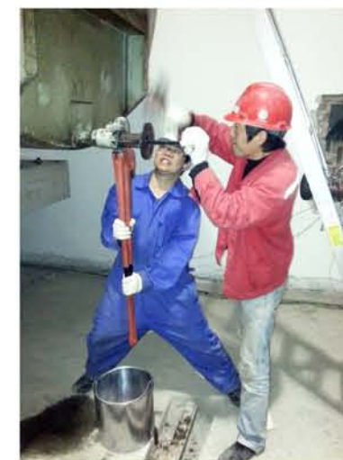
主变油罐排油管紧固
