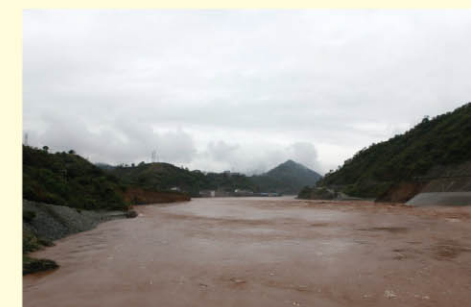
围堰下游汛期过水情况
