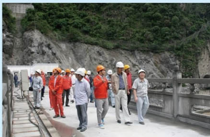
专家组在拦河闸坝工程现场查勘
