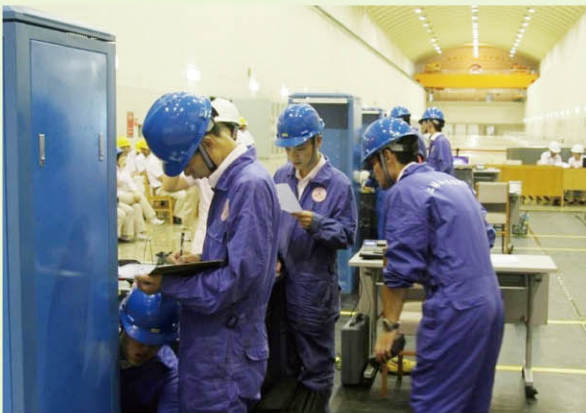
二次配线——检修技能比武
