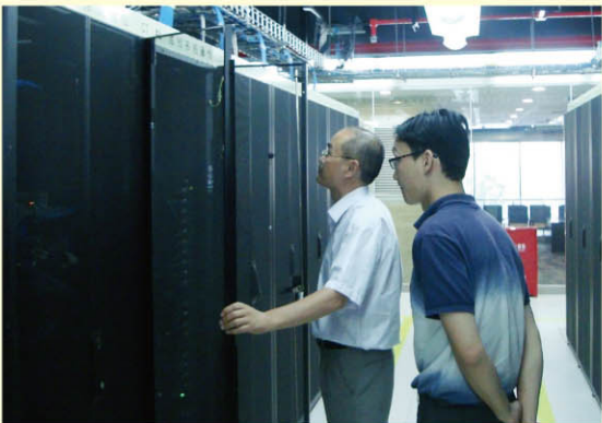
集控中心现场检查
