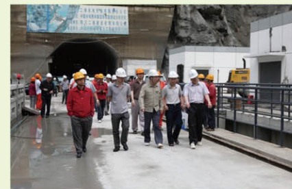
蓄水安全鉴定专家组在拦河闸坝工程现场查勘
