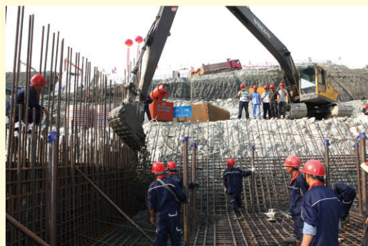
首仓混凝土浇筑现场
