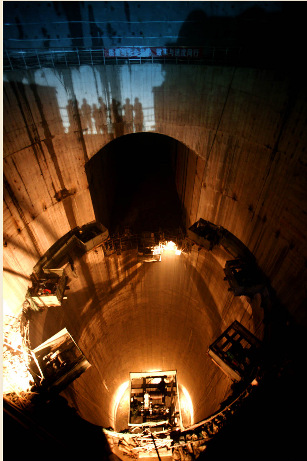
灯火阑珊的调压室施工 代建梅
