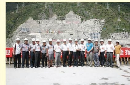
调研组在锦屏一级水电站大坝考察并留影
