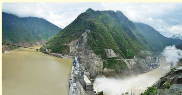
电站枢纽区全景
