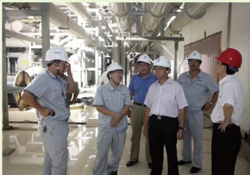
现场检查锦屏二级水电站GIS安装工作
