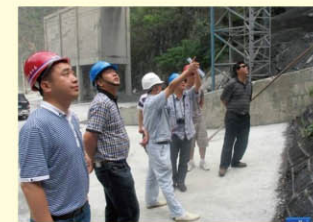
检查组检查印把子渣场底部挡护设施
