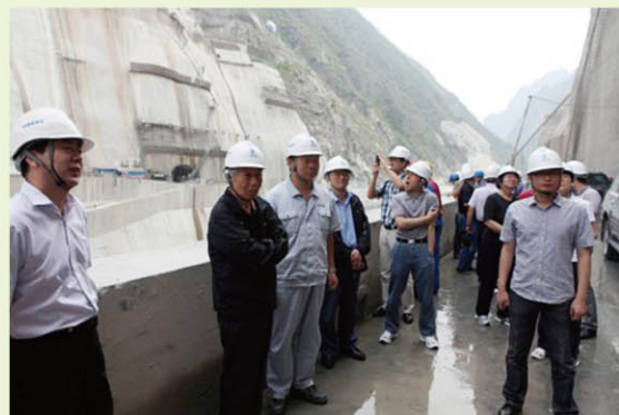
安全鉴定专家组查勘现场
