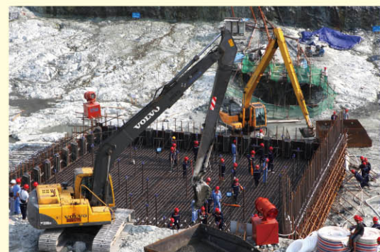
首仓混凝土浇筑现场
