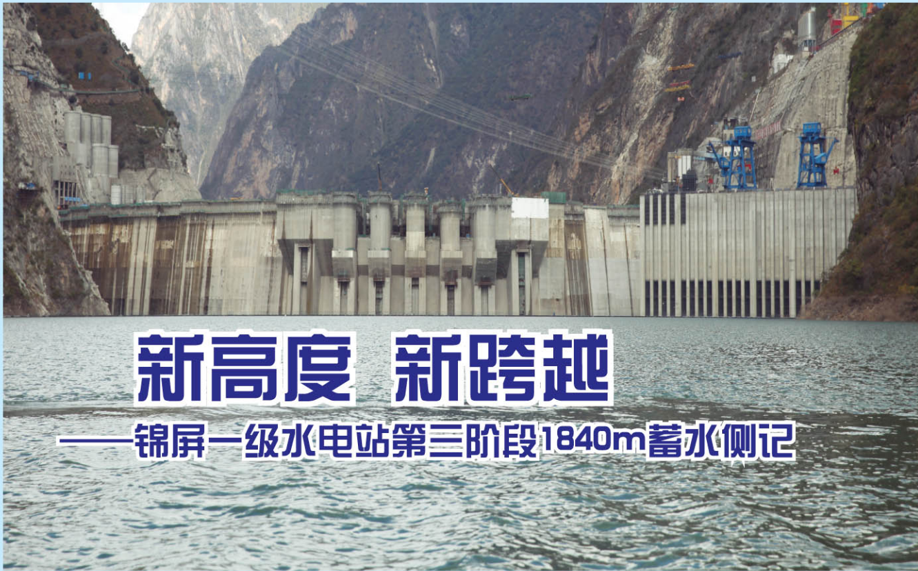
公司锦屏水力发电厂 邓 庆
