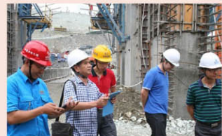
施工现场检查
