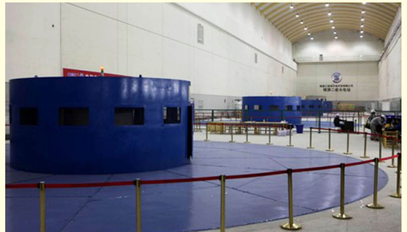
4台机组投入商业运行
