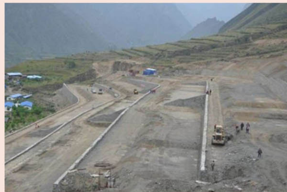
安置点场坪全貌
