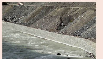
复建路沿江渣场防护
