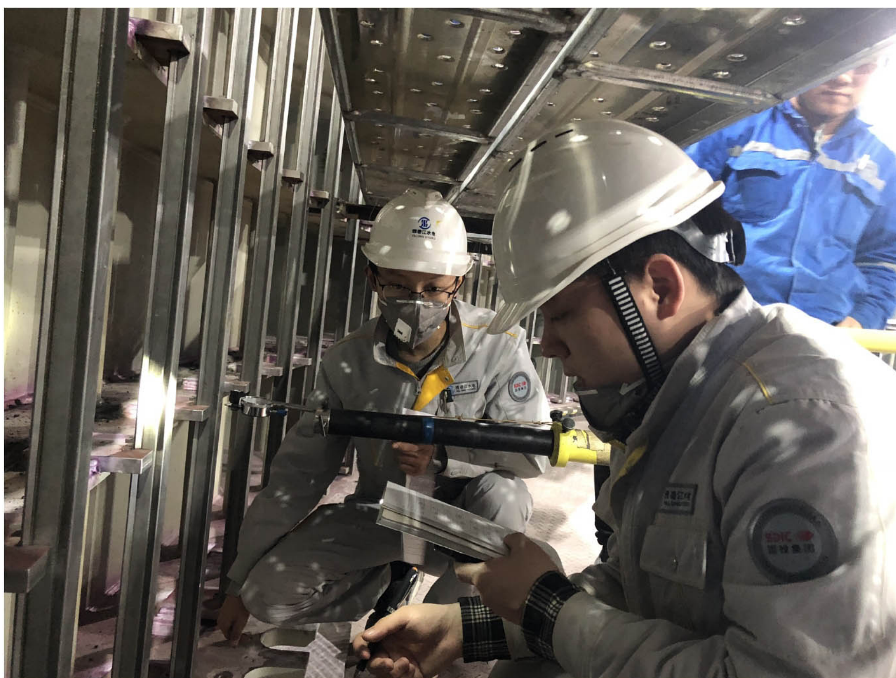
定位筋焊前验收 王攀/摄
