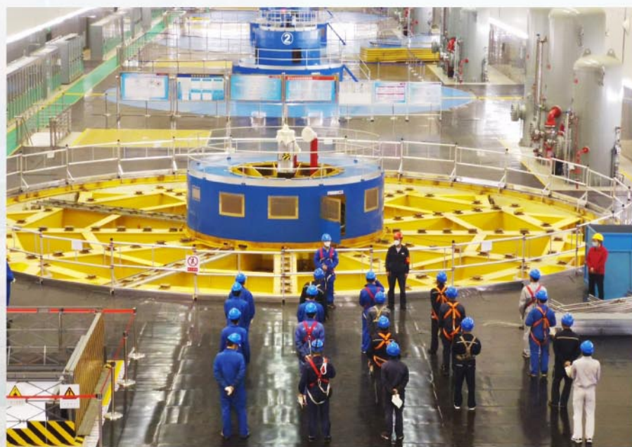
大型起重作业前，组织专项安全技术交底 黄郭明/摄
