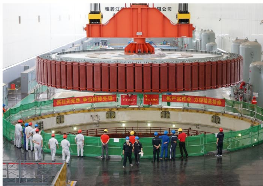
机组A修转子回装现场 沈乐扬/摄
