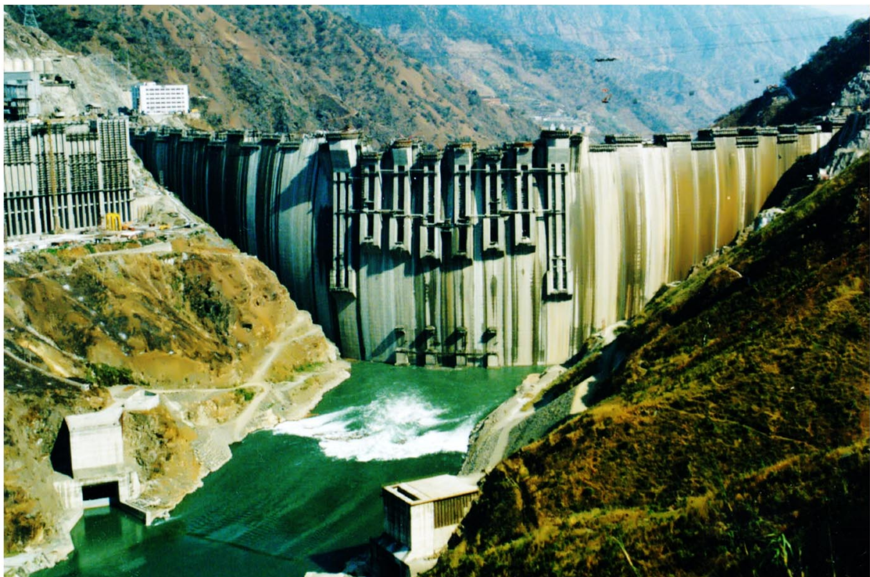
建设中的二滩水电站 宋志评 / 摄
