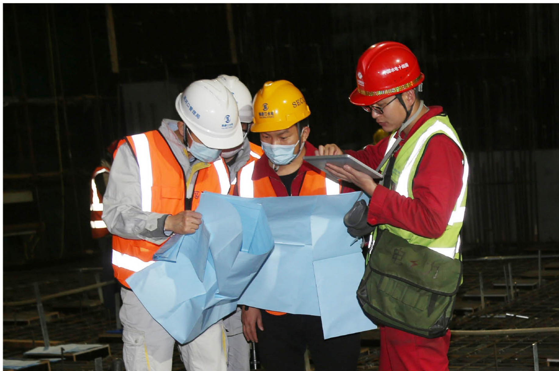
■ 现场工作 两河口水力发电厂（筹）/ 蒋宜杰
