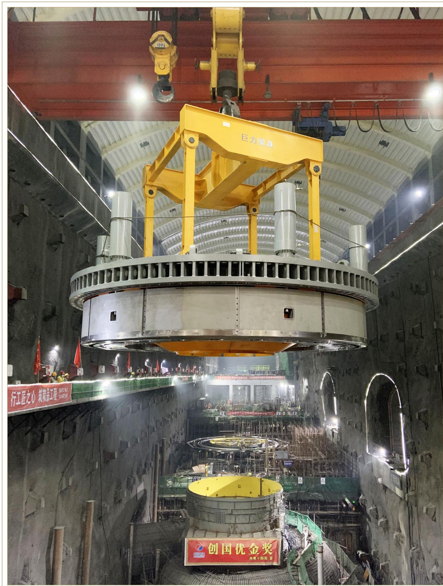
■ 机组顶盖及筒阀吊装 两河口水力发电厂（筹）/ 尹志富
