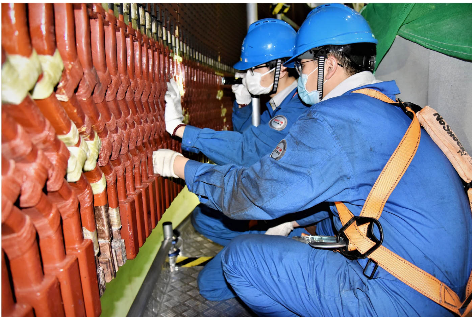
桐子林水电站1号机组A修 刘华峰/摄
