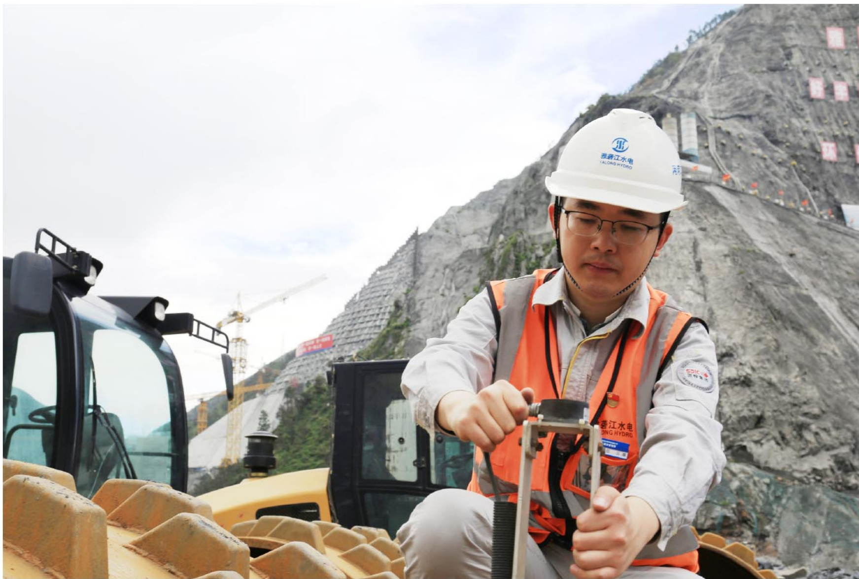
调试无人碾压定位设备 陈舒航 / 摄
