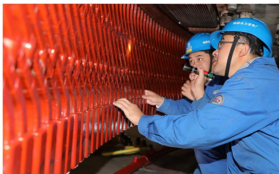
■ 锦屏一级水电站发电机检修
