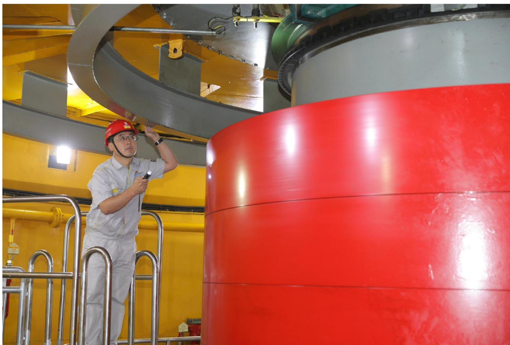
在锦屏一级水车室检查下导轴承运行情况 高国峰/摄
